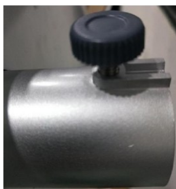
Správne dotiahnutý upevňovací prvok po osadení panelu.
